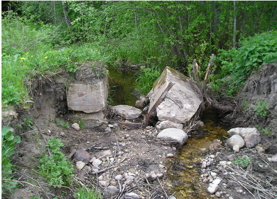
3. Lagunenud nõukogudeaegne regulaator Majori järve väljavoolul, vaade allavoolu (02.06.2004).
